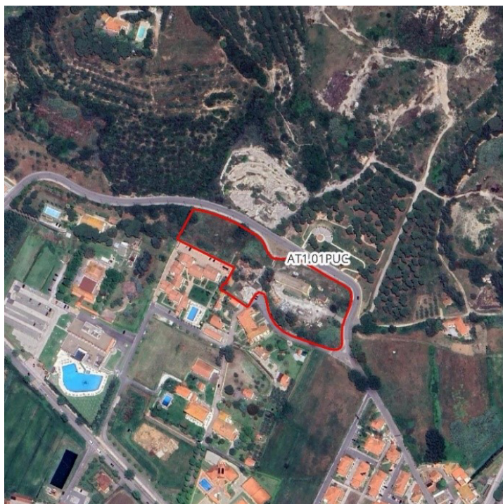
Figura 6-1: Area di trasformazione AT1.01PUC – RECUPERO EX FORNACE.
