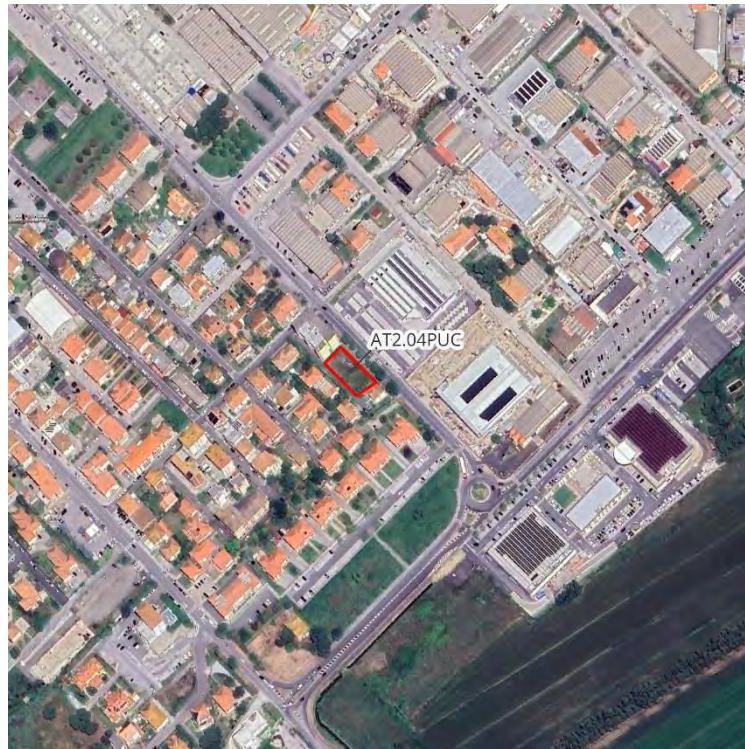
Figura 4-10: Area di trasformazione AT2.04PUC – LOTTO RESIDENZIALE, VIA DELLA FIERA.
