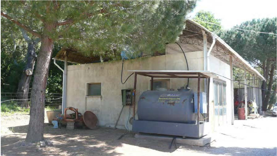
Fabbricato 2a - FOTOGRAFIA 9
