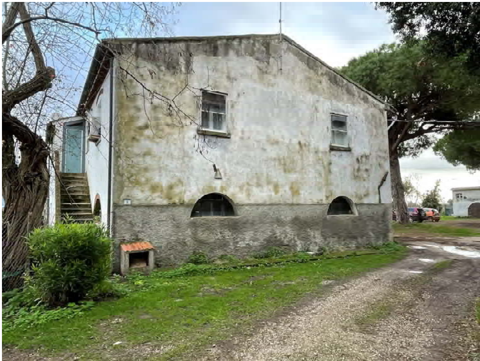
Foto 8_ FABBRICATO 1b – Prospetto laterale
