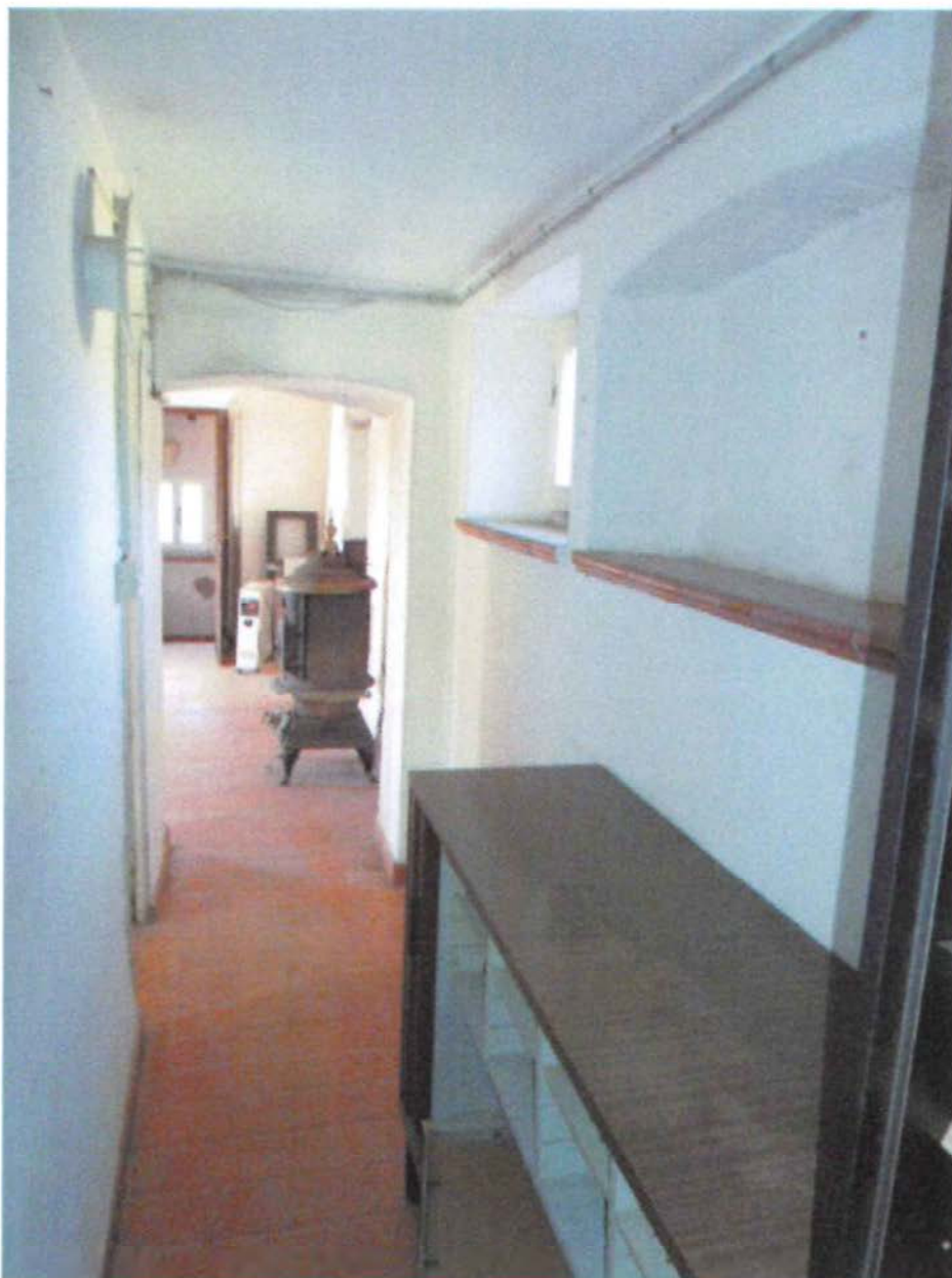
Interni - Piano primo – Disimpegno 4
