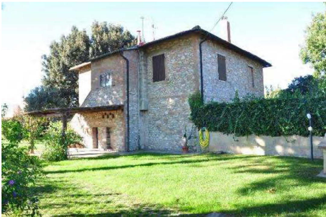
FOTO 2 prospetti NORD-EST e NORD-OVEST
