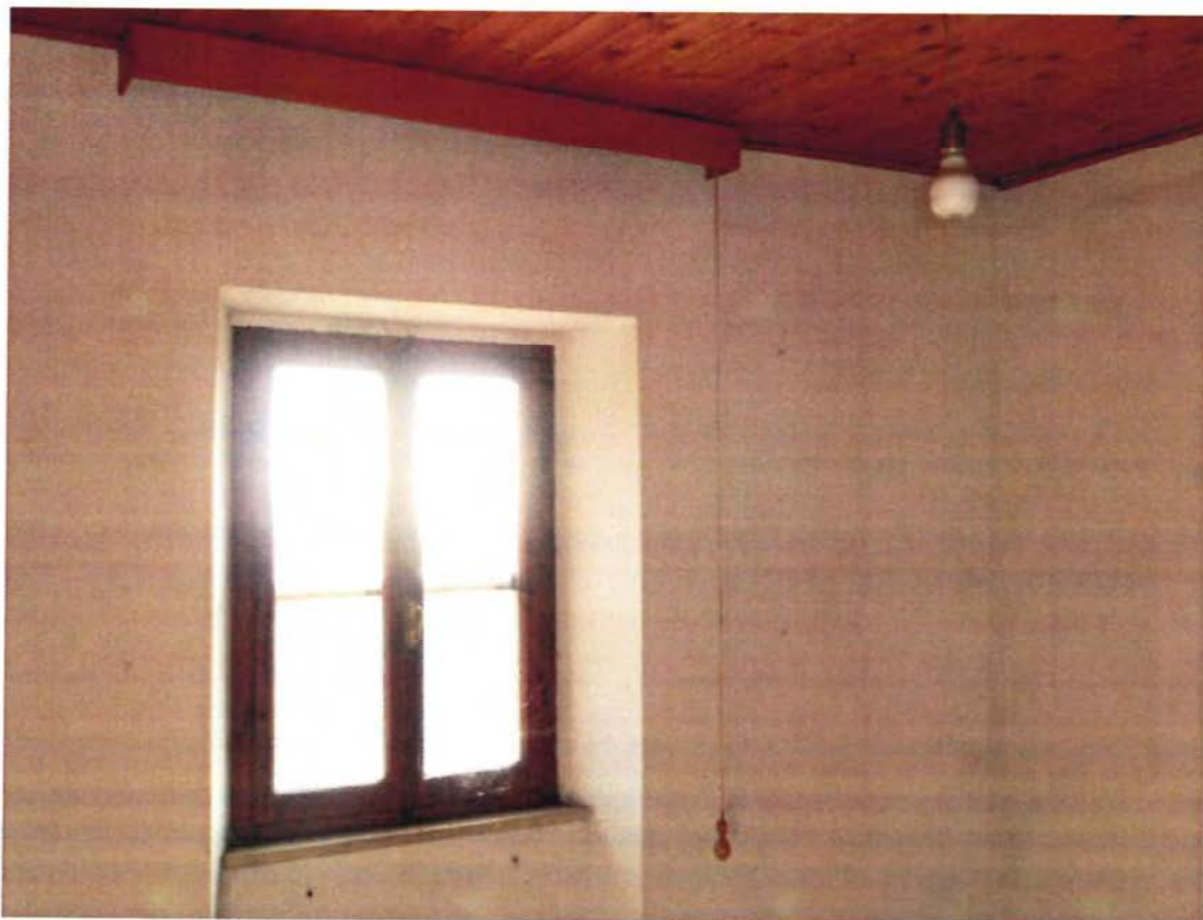
Foto n. 9 - Edificio 1b - Interni – Abitazione (sub 3) – P.T. Camera 2
