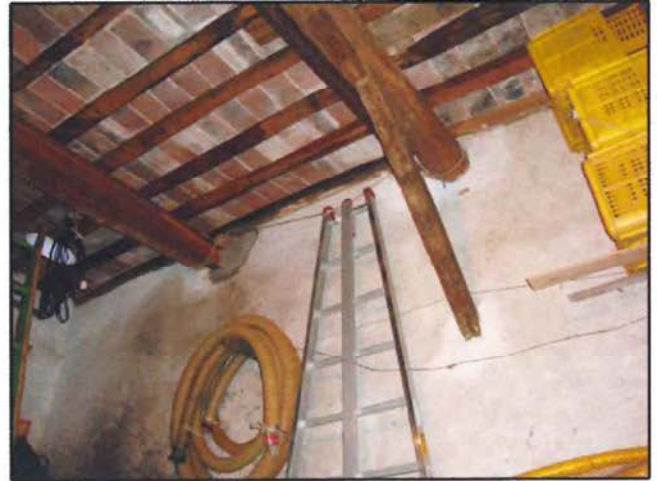
SOLAIO INTERPIANO (EDIFICIO 1a)
