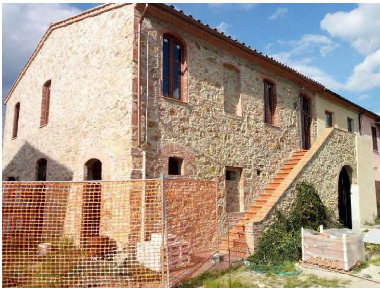
Corpo scala esterna lato sud
