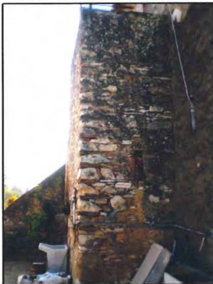
CORPO SCALA (EDIFICIO 1a)
