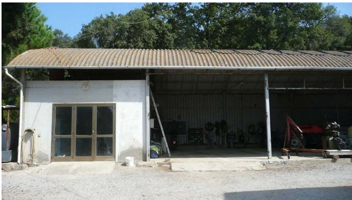
Fabbricato 2a - FOTOGRAFIA 7
