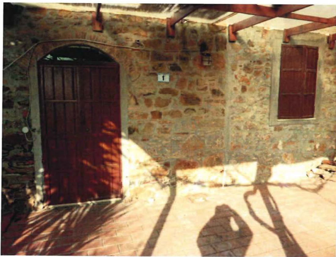
Foto n. 6 – Edificio 1 - Particolare prospetto Sud - Est
