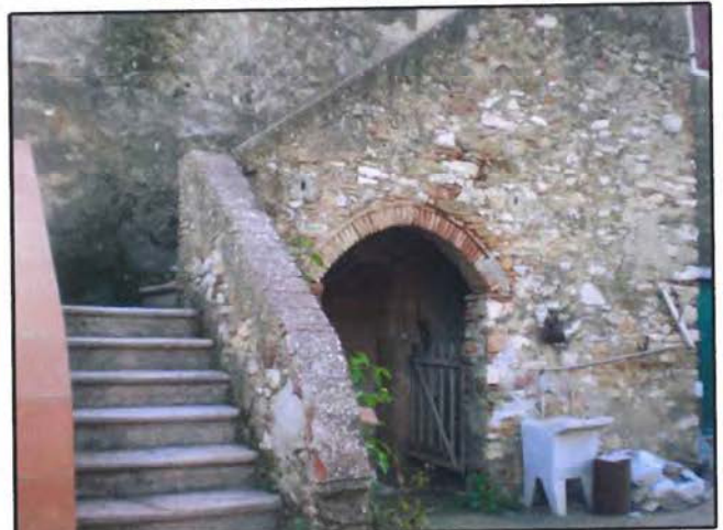
CORPO SCALA (EDIFICIO 1a)
