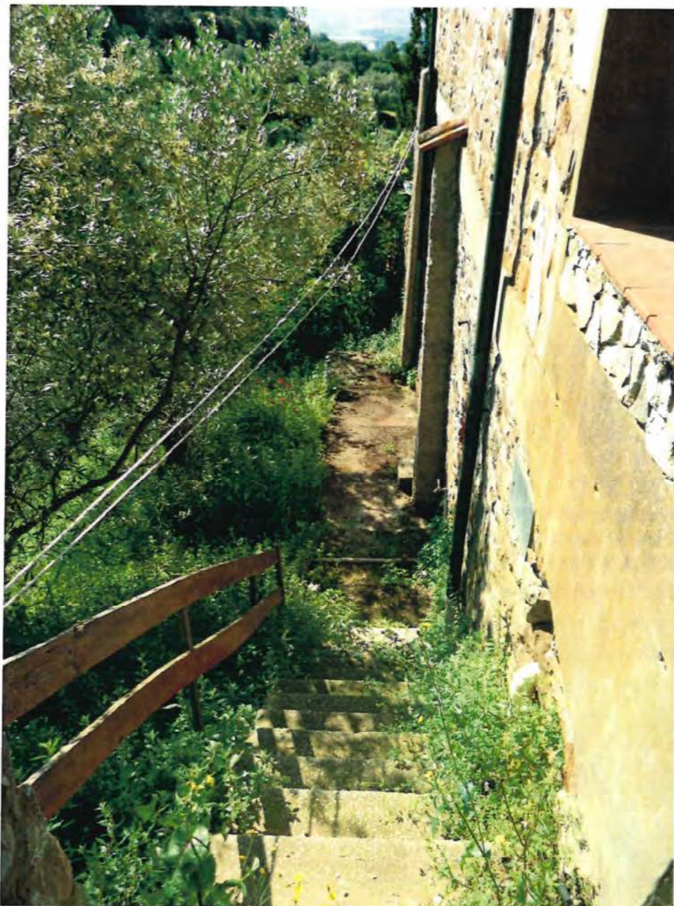
Foto n. 1 – Edificio 1 - Prospetto Nord - Est
