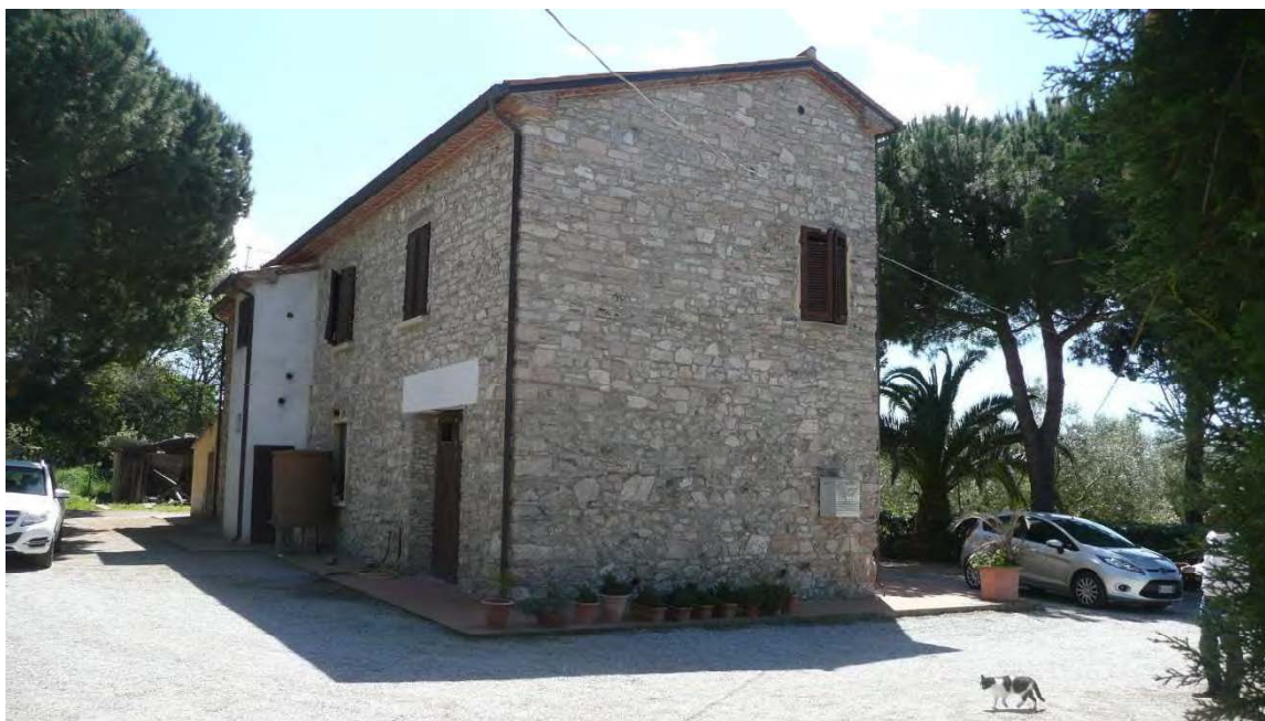
Fabbricato 1a - FOTOGRAFIA 3
