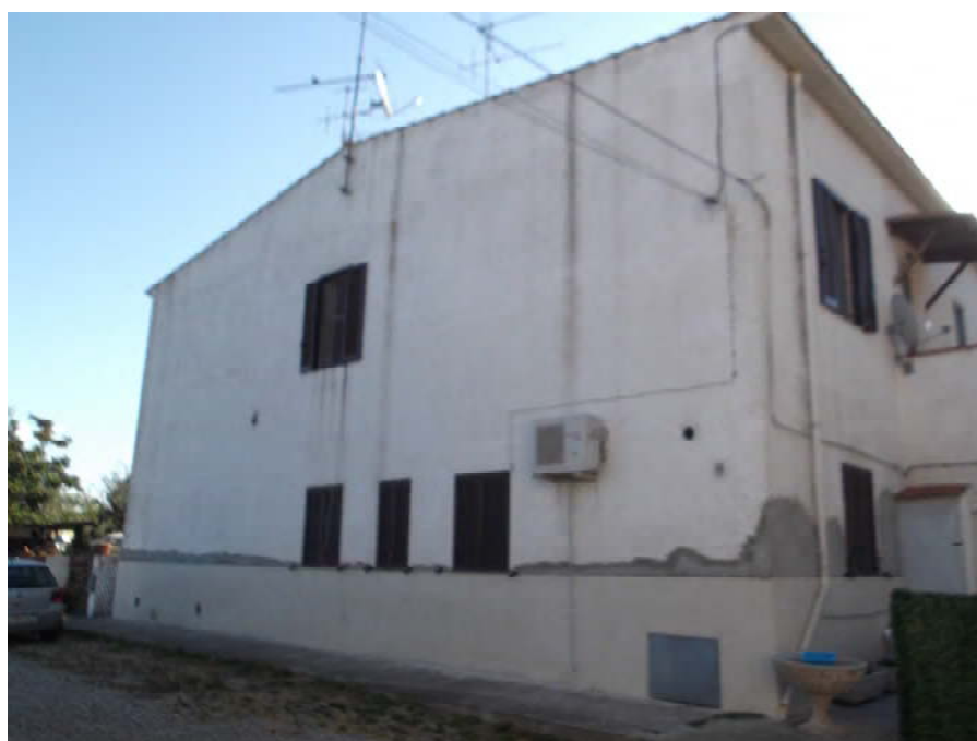
Foto 2 _ FABBRICATO 1a – Prospetto laterale
