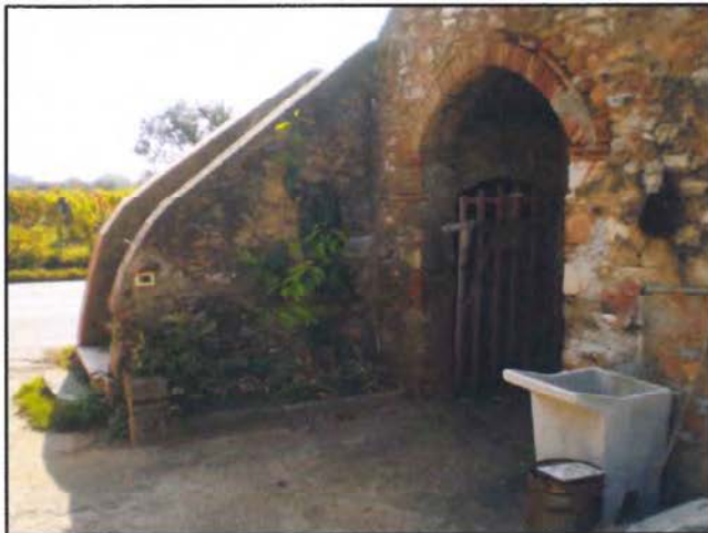
CORPO SCALA (EDIFICIO 1a)
