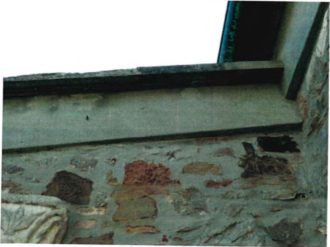
Foto n. 3 – Edificio 1 - Particolare prospetto Nord - Ovest
