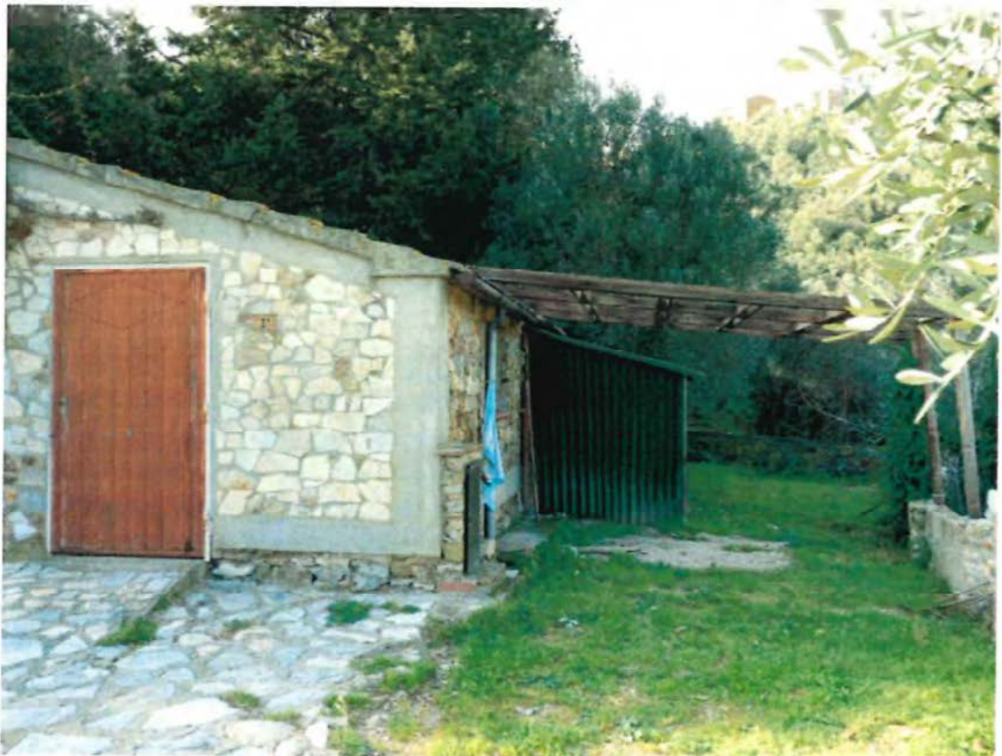
Foto n. 16 – Edificio 2a e 2b- Monolocale – Prospetto Sud- est/ Nord-est
