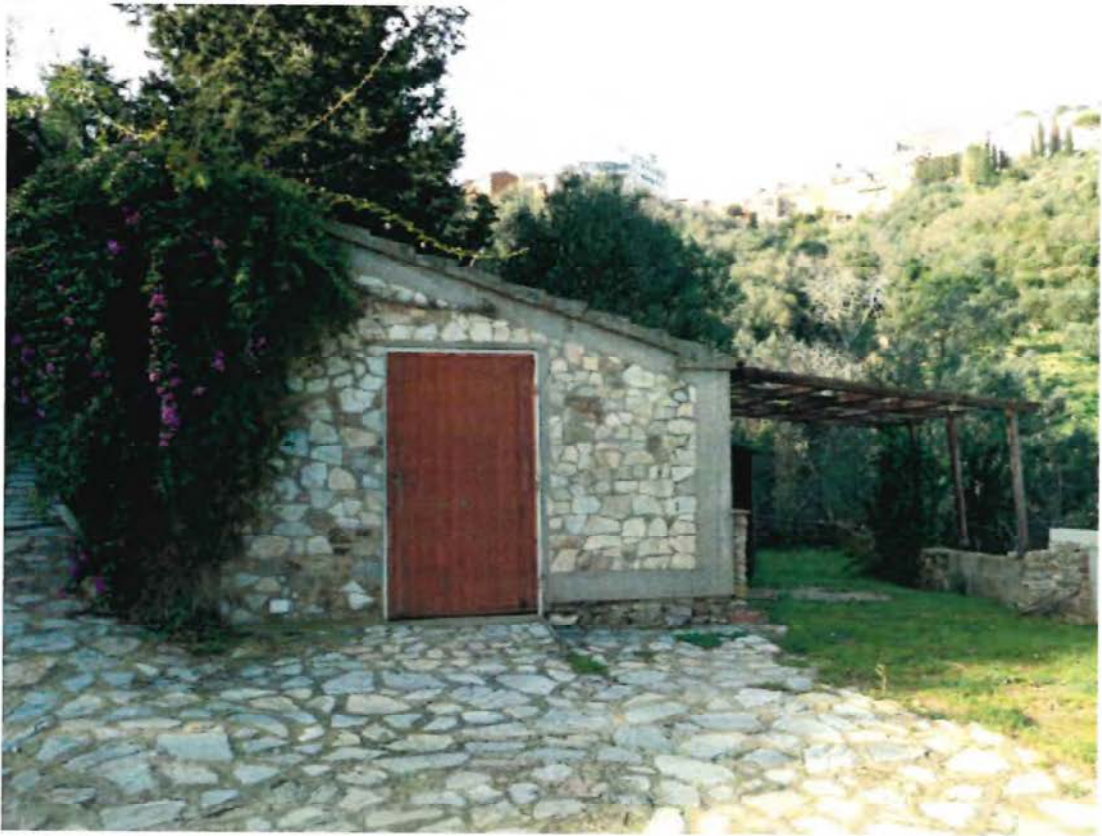
Foto n. 15 - Edificio 2a- Monolocale (sub 601) – Prospetto Sud - est
