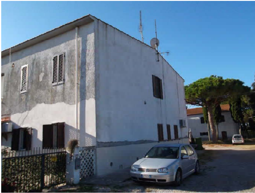
Foto 5 _ FABBRICATO 1a – Prospetto laterale
