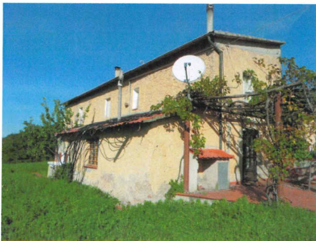
Foto n. 2 - Prospetto Sud-Est – edificio "1"
