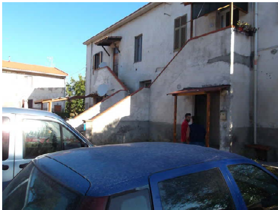
Foto 1 _ FABBRICATO 1a - Prospetto principale
