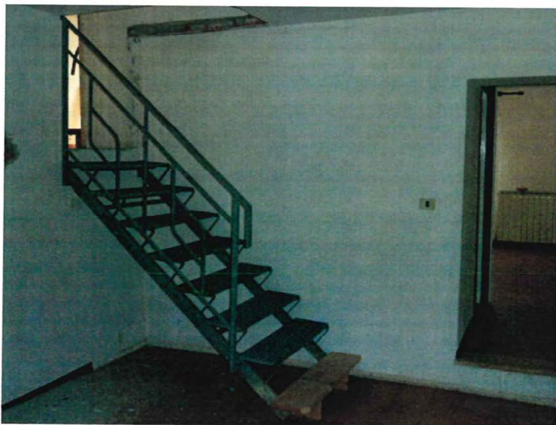
Foto n.10 - Edificio 1b - Interni – Abitazione (sub 3) – P. 1°seminterrato Ingresso
