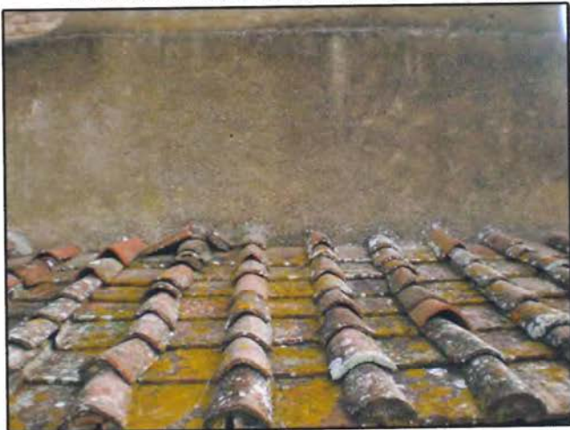
MANTO DI COPERTURA (EDIFICIO 1c)
