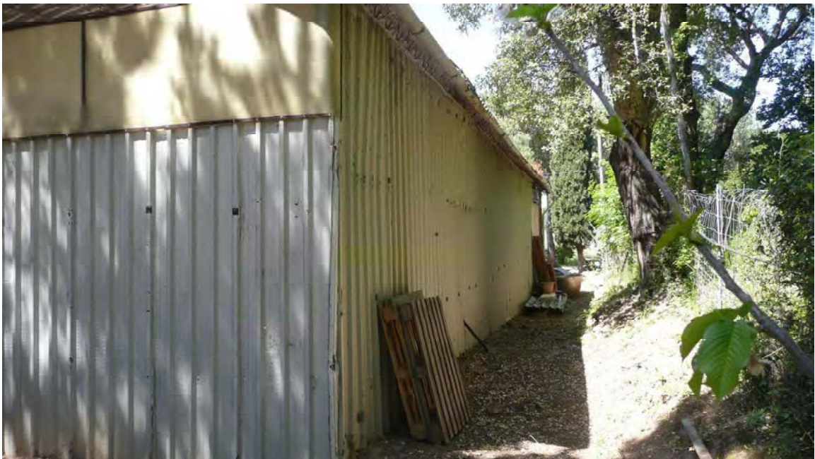
Fabbricato 2a - FOTOGRAFIA 10
