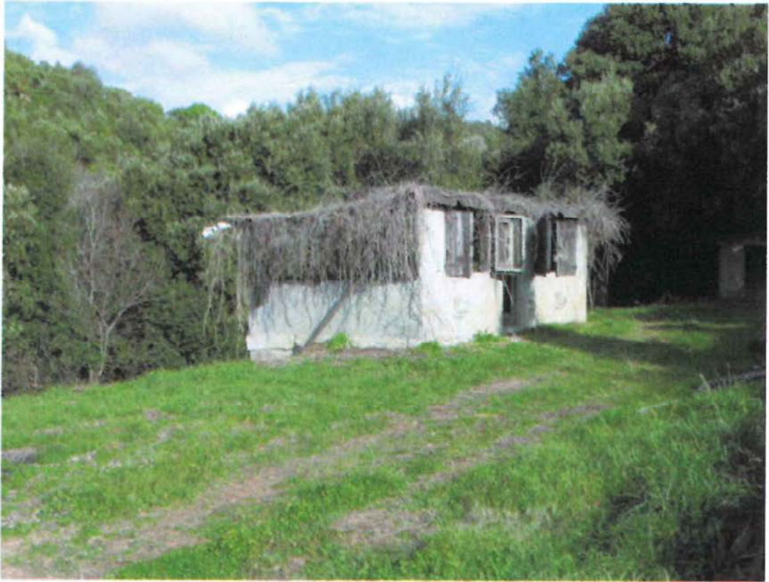
Foto n. 8 - Prospetto Sud-Est – Annesso “2”
