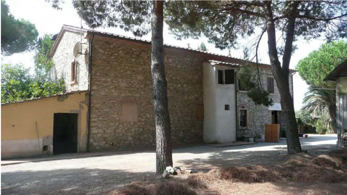
Fabbricato 1a - FOTOGRAFIA 5
