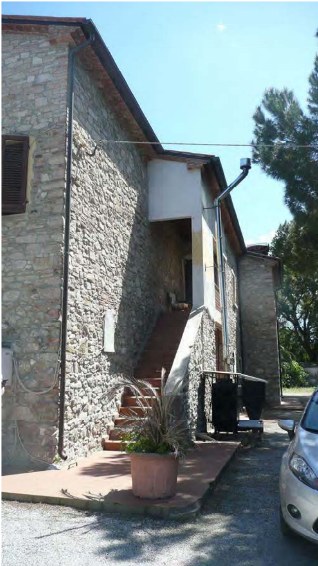
Fabbricato 1a - FOTOGRAFIA 2
