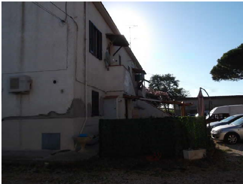
Foto 6 _ FABBRICATO 1a – Prospetto laterale
