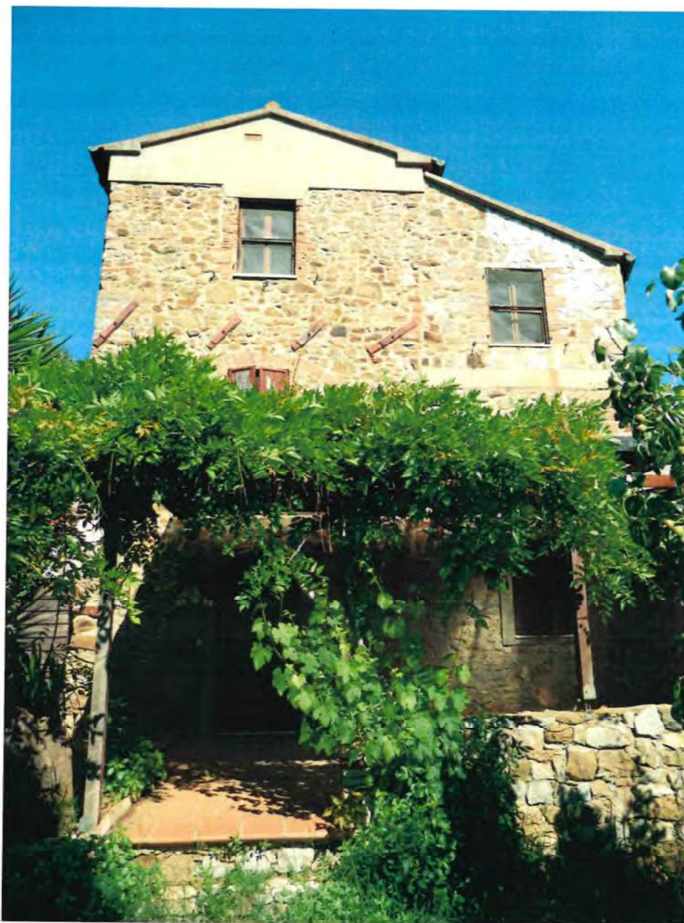
Foto n. 2 – Edificio 1 - Prospetto Sud - Est
