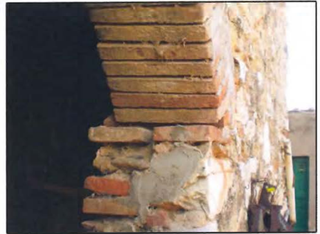
MURATURA PORTANTE CORPO SCALA E IMPOSTA ARCO SOTTOSCALA (EDIFICIO 1a)
