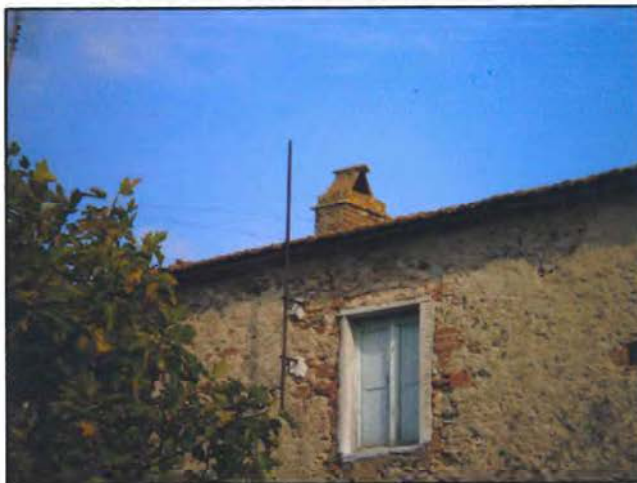
COMIGNOLO IN MURATURA (EDIFICIO 1a)
