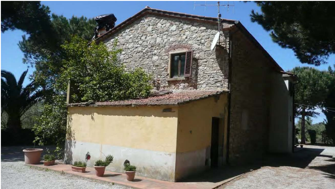
Fabbricato 1a - FOTOGRAFIA 1
