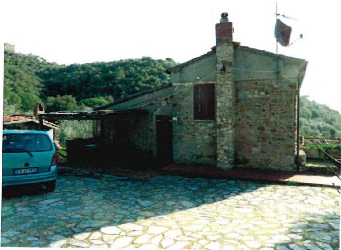
Foto n. 4 – Edificio 1 - Prospetto Nord - Ovest
