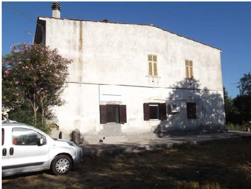
Foto 3 _ FABBRICATO 1a – Prospetto laterale
