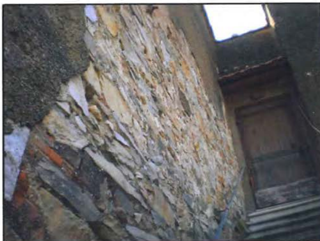
MURATURA PORTANTE (EDIFICIO 1a)
