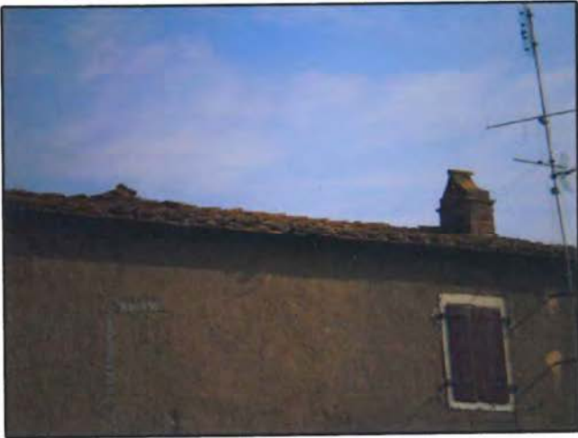
MANTO DI COPERTURA (EDIFICIO 1a)
