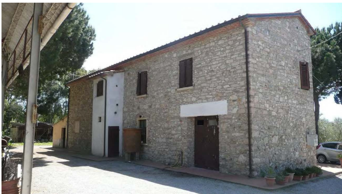
Fabbricato 1a - FOTOGRAFIA 4
