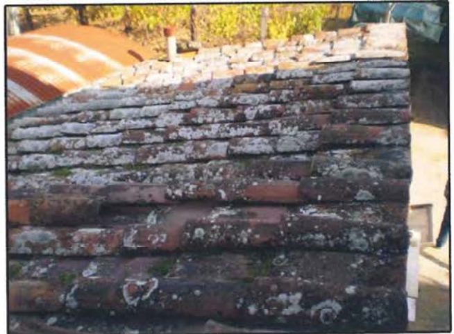
MANTO DI COPERTURA (EDIFICIO 1b)
