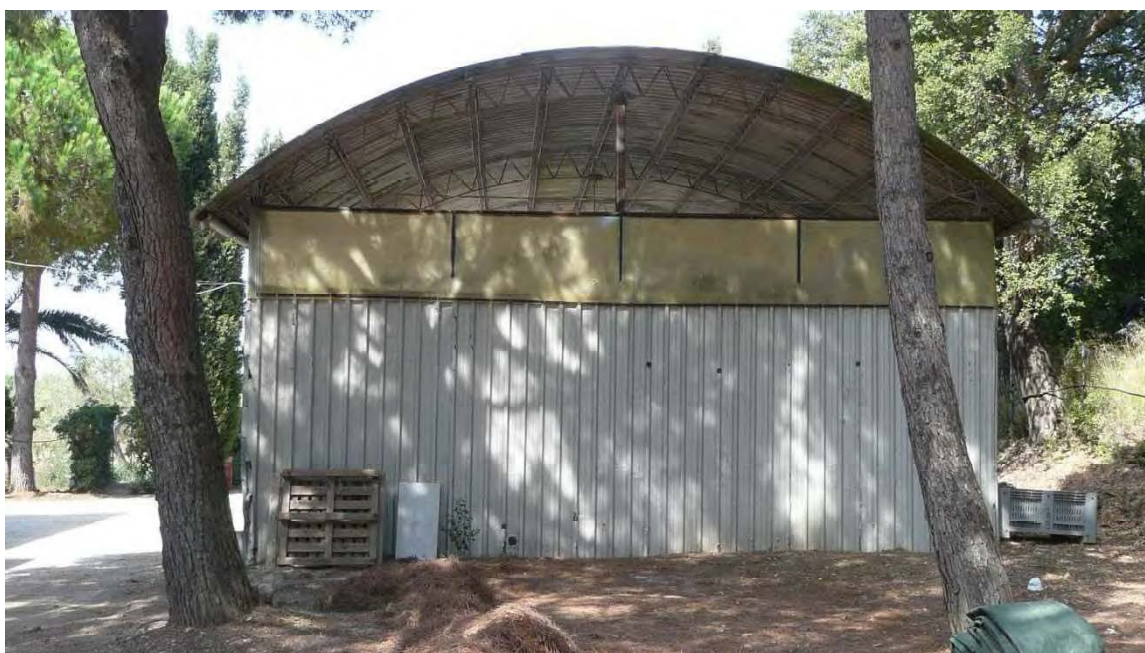
Fabbricato 2a - FOTOGRAFIA 8
