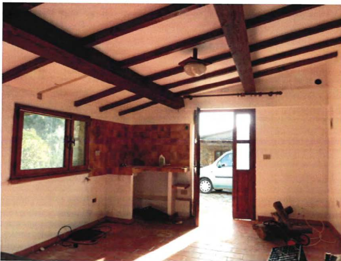
Foto n. 17 - Edificio 2a- Interni – Monocale (sub 601)
