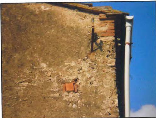
GRONDA (EDIFICIO 1a)
