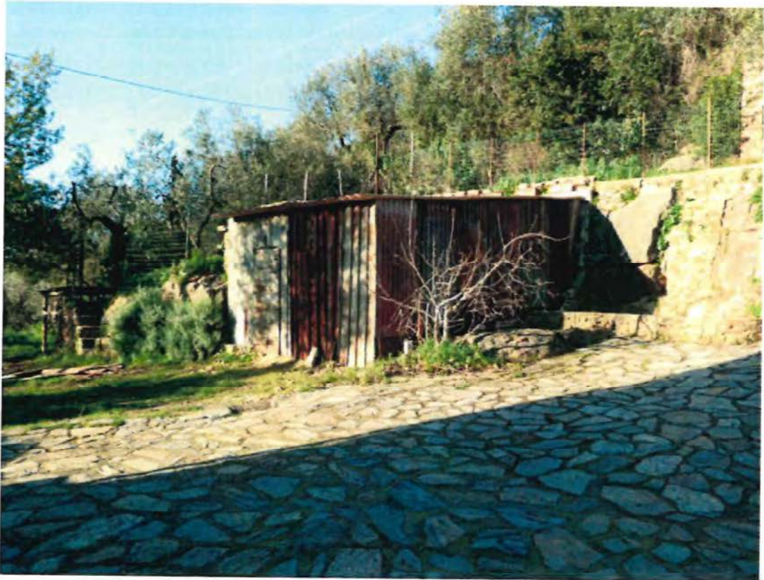
Foto n. 19 – Edificio 3- Magazzino (sub 602)
