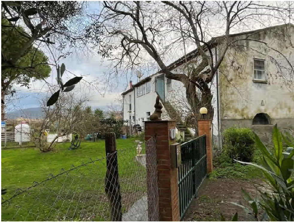
Foto 9 _ FABBRICATO 1b – Prospetto secondario
