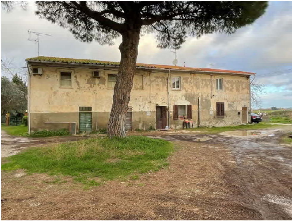
Foto 7_ FABBRICATO 1b - Prospetto principale
