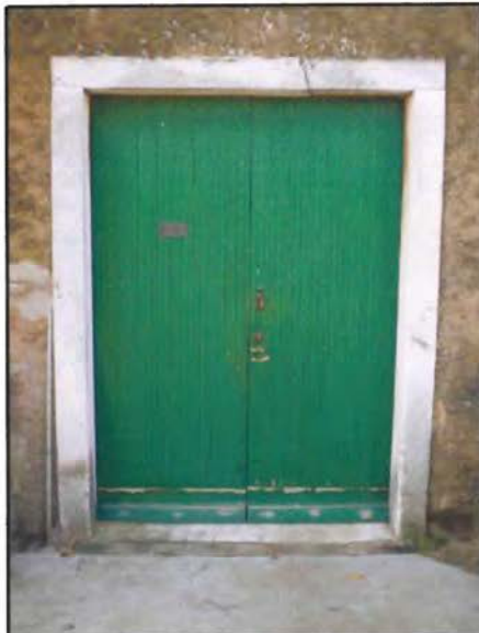
PORTA INGRESSO CANTINA AL P.T. (EDIFICIO 1a)
