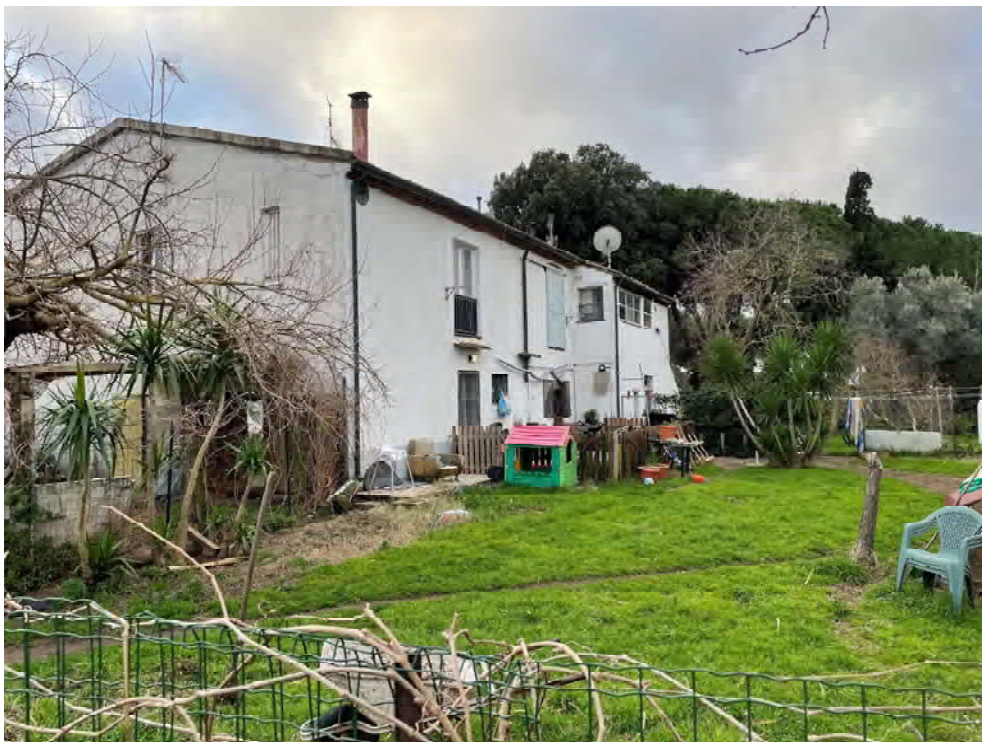
Foto 10 _ FABBRICATO 1b – Prospetto secondario e laterale
