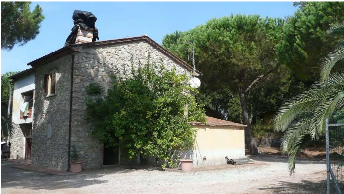
Fabbricato 1a - FOTOGRAFIA 6
