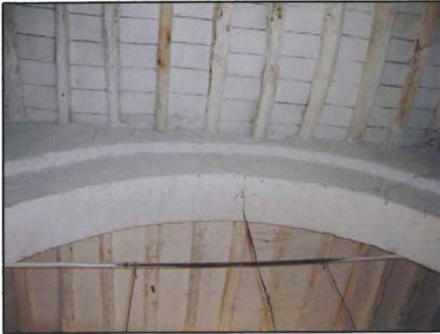
SOLAIO INTERPIANO (EDIFICIO 1a)
