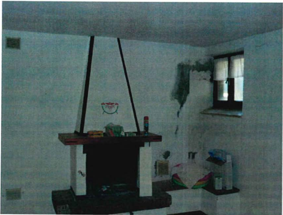
Foto n.11- Edificio 1b - Interni - Abitazione (sub 3) – P. 1° seminterrato Ingresso
