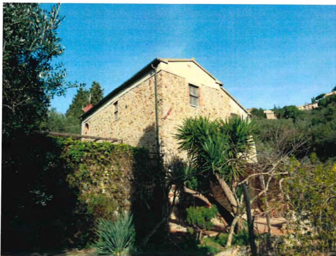
Foto n. 5 - Edificio 1 - Prospetto Sud-Est / Sud-Ovest
