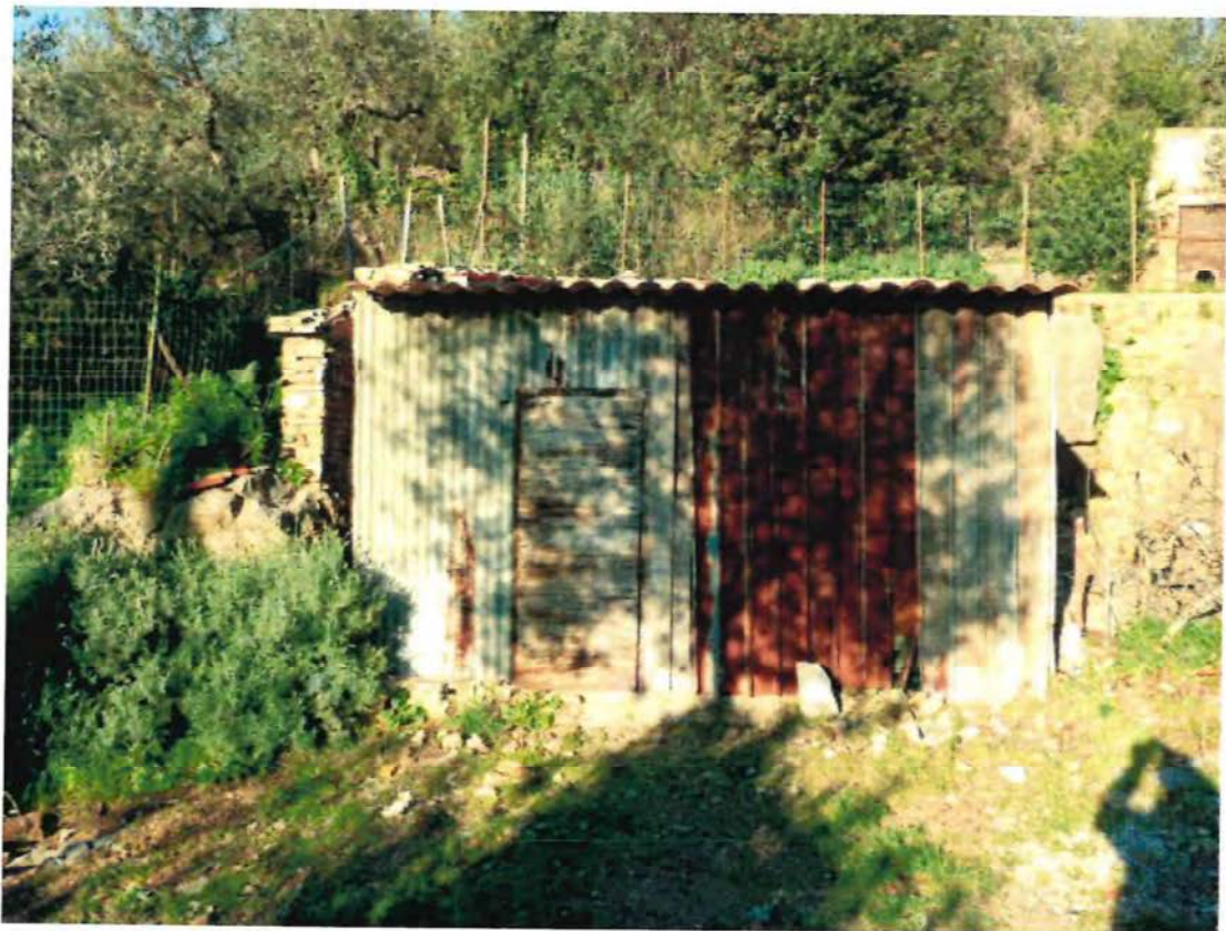
Foto n. 20 – Edificio 3- Magazzino (Sub 602)
