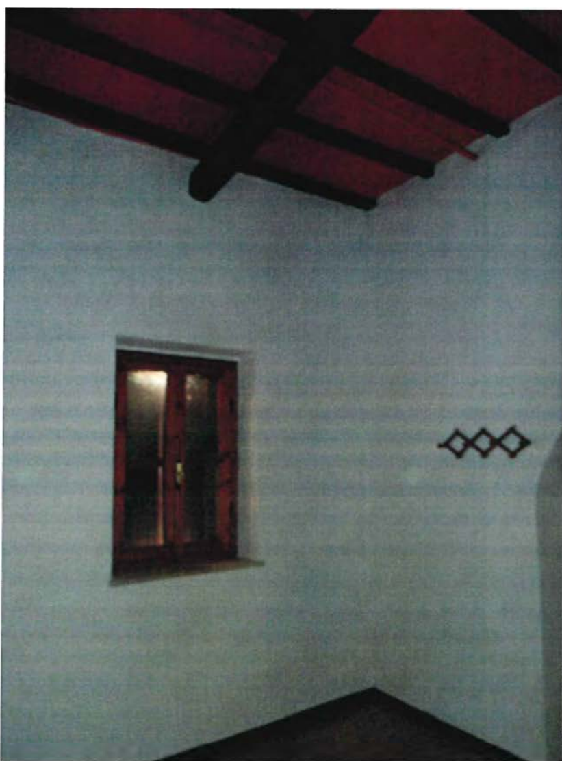
Foto n. 14 - Edificio 1a - Interni Abitazione (sub 3) – P.T. Camera 1
