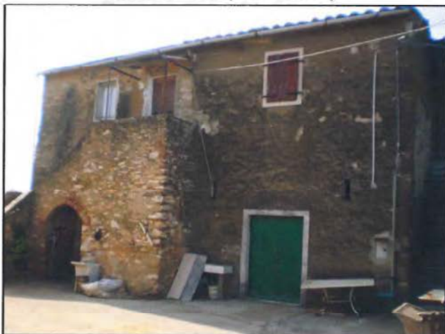
FOTO N ° 100 (EDIFICIO 1)
