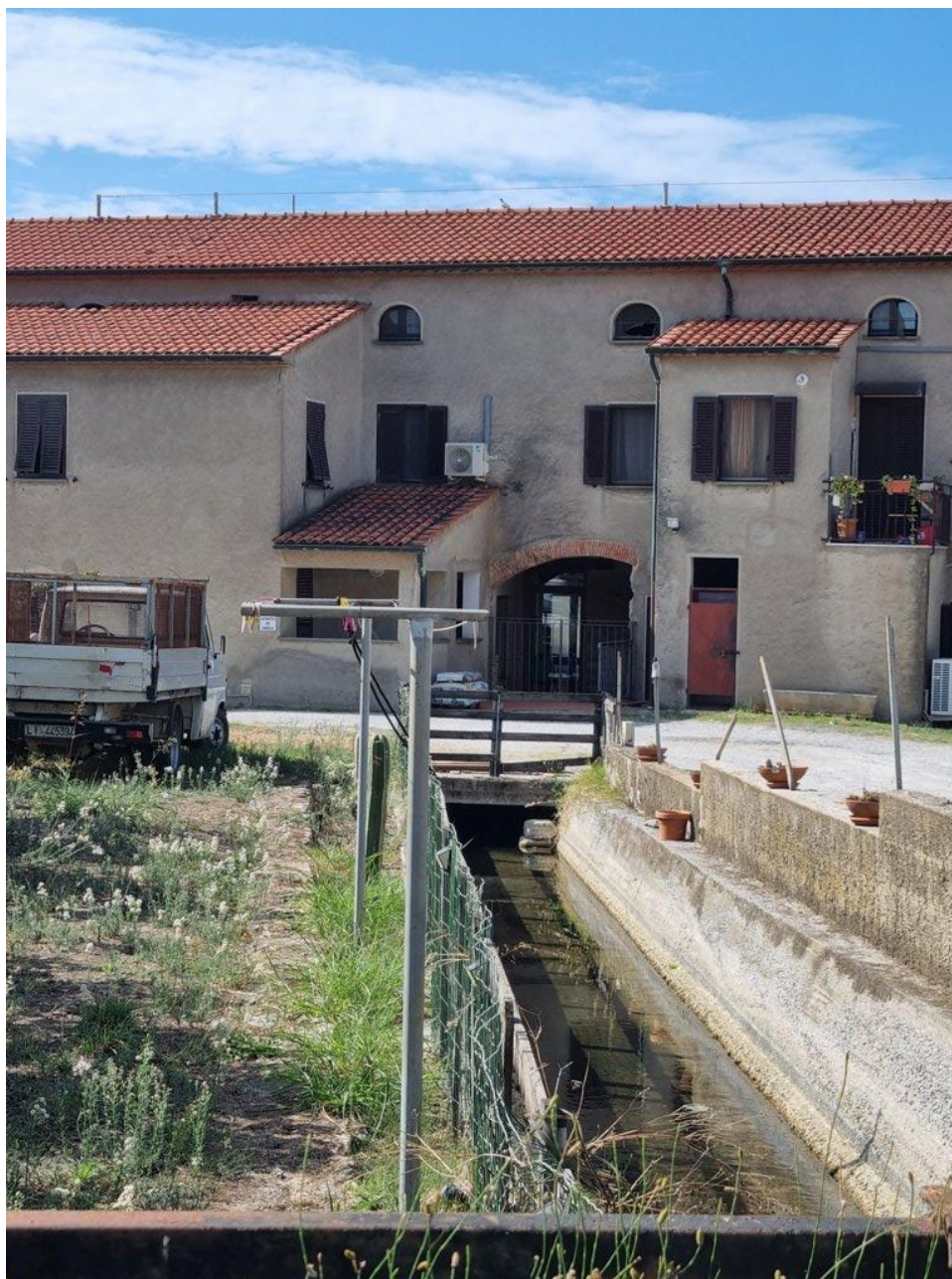
Figura 5 - Rilievo sul Fossa Calda, tombamento nei pressi di Via dei Molini
