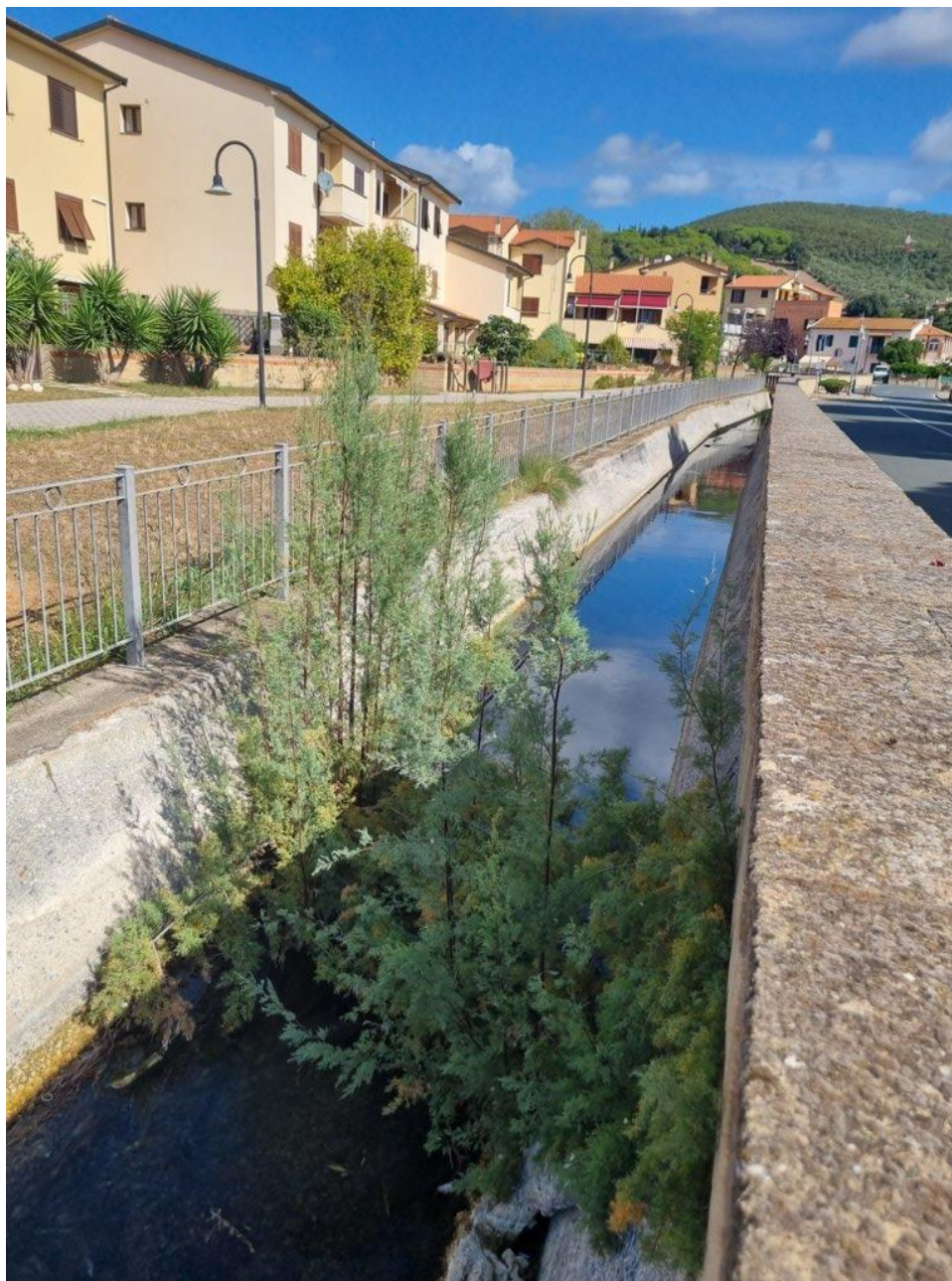
Figura 6 – Fossa Calda – rilievo a monte del tombamento in Via dei Molini
